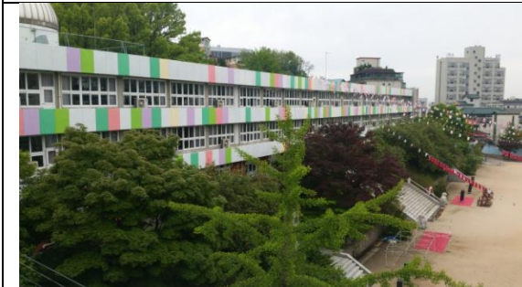
更換門窗 (第一棟大樓)
