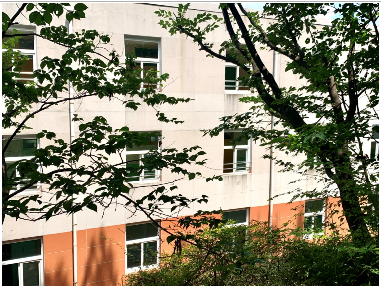
A 棟大樓後側
