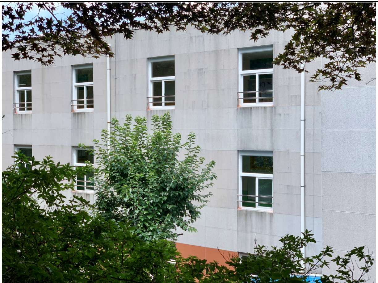
A 棟大樓後側
