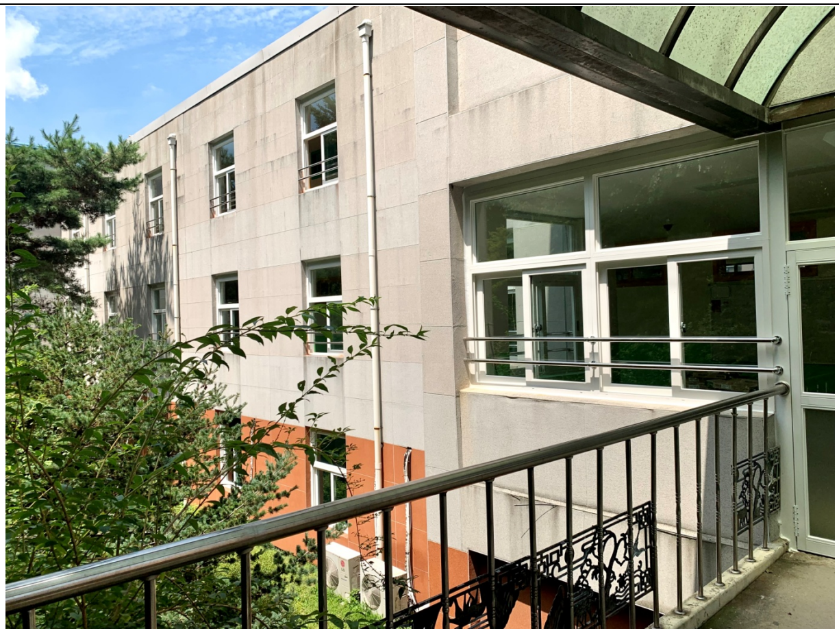
A 棟大樓通往光華園的天橋
