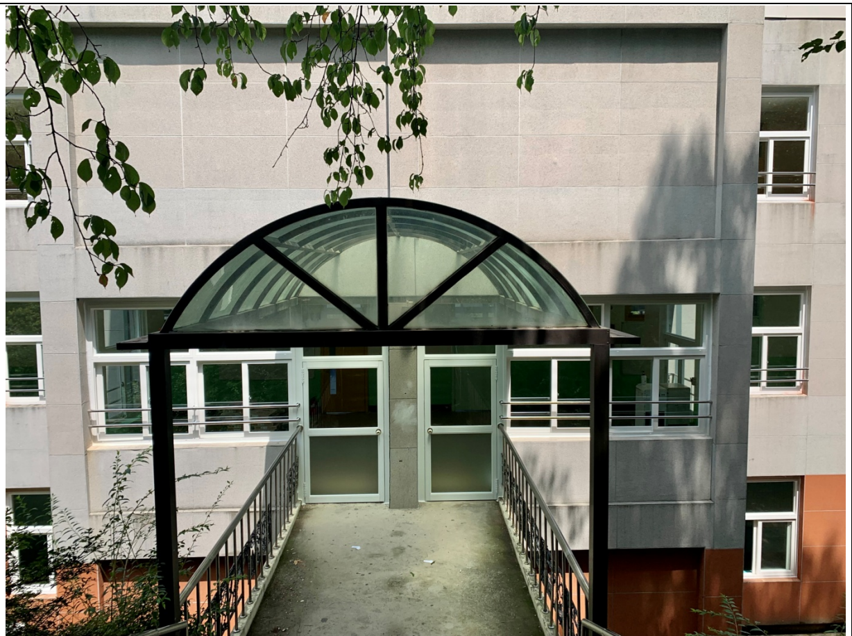
A 棟大樓通往光華園的天橋
