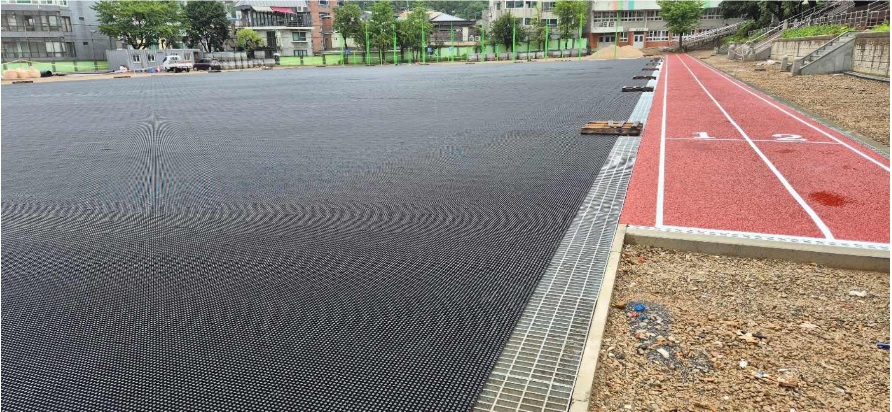
球場鋪設排水版，跑道劃線
