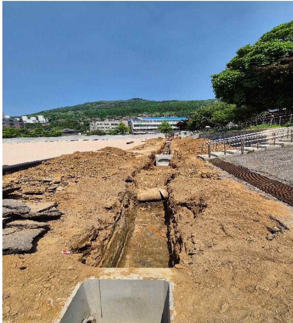
最外側排水管
