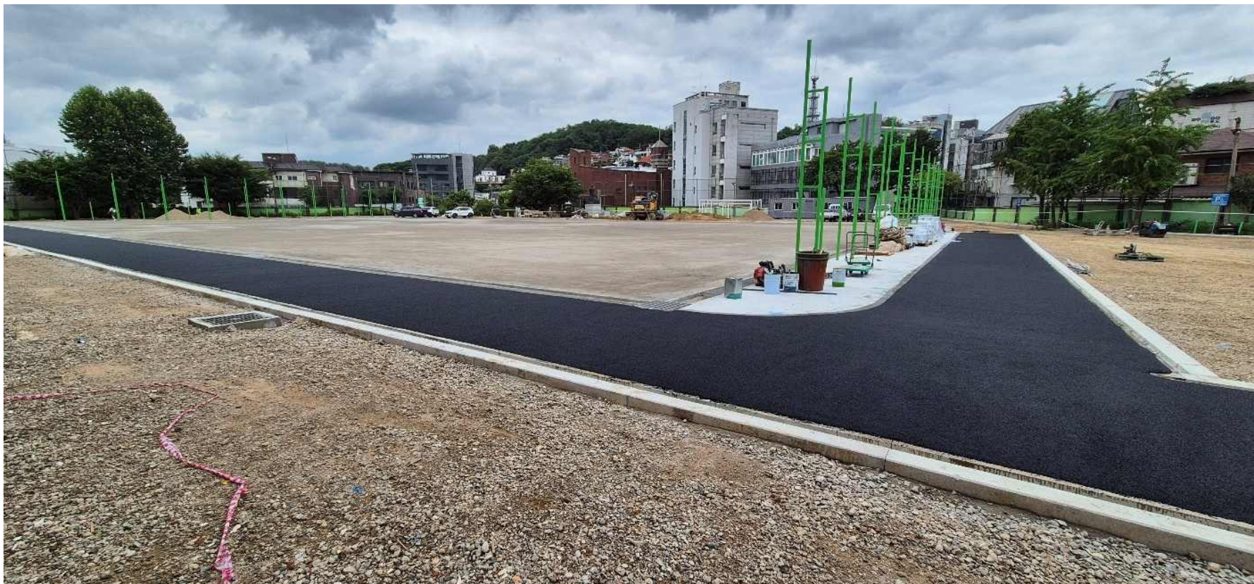
跑道鋪設橡皮碎片後油漆
