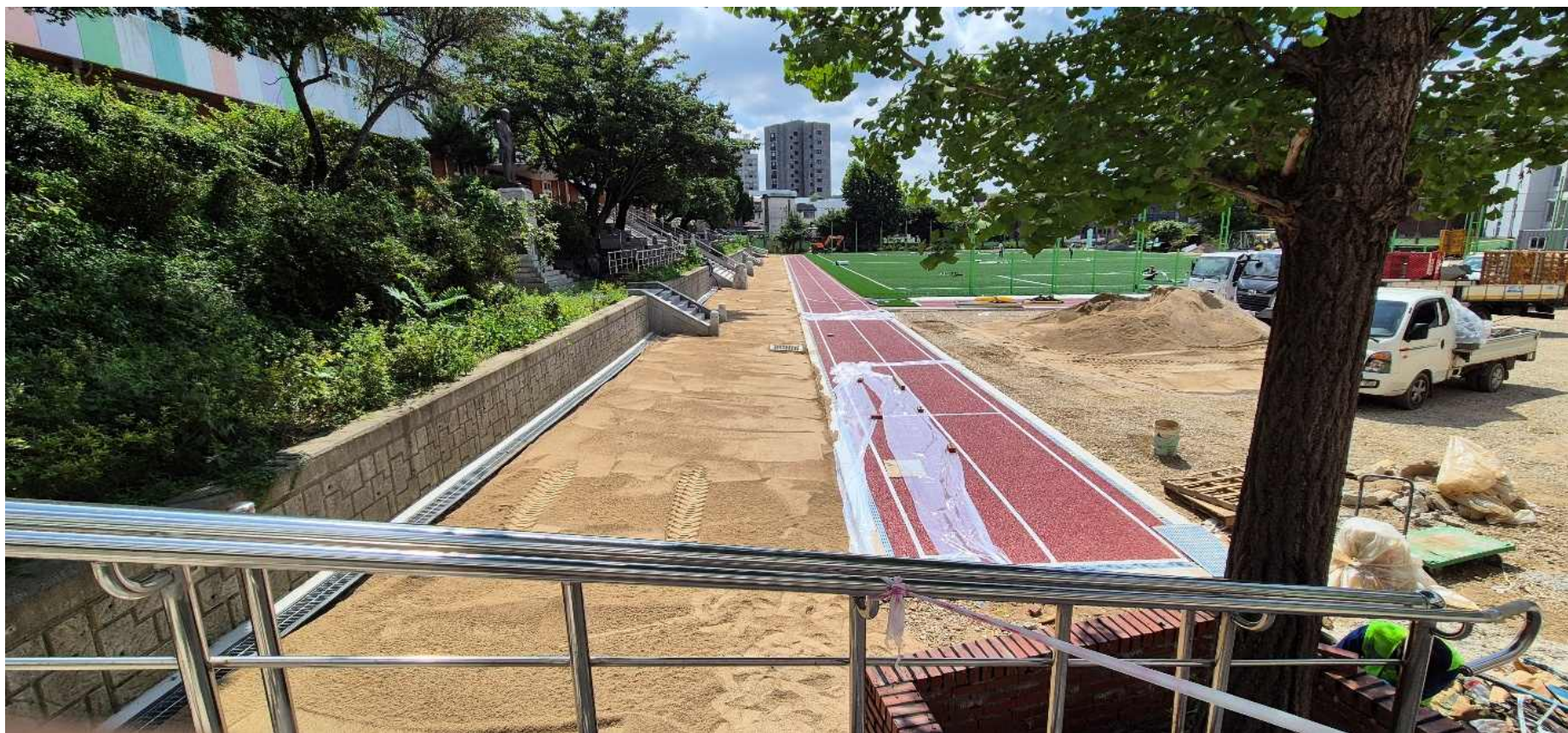
司令台前在鋪磚之前先鋪沙子
