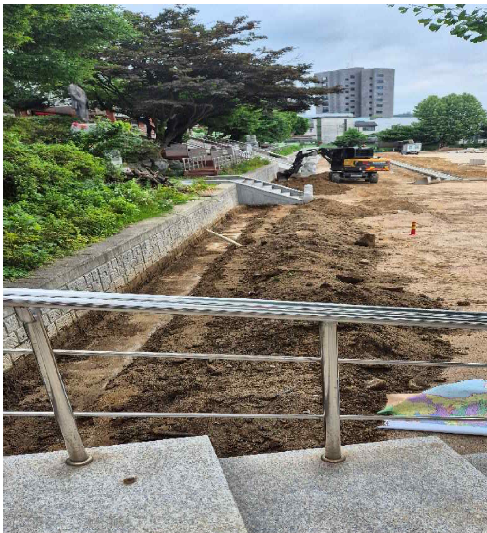
重埋設擋土牆邊排水管以便排洩第一大樓下積水
