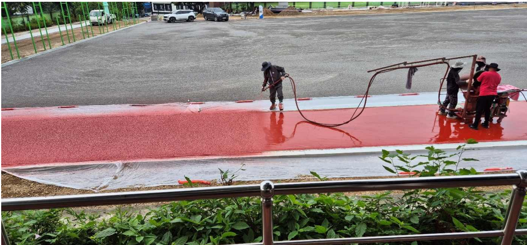
經過兩次油漆後，以樹酯混合橡膠顆粒噴鋪跑道
