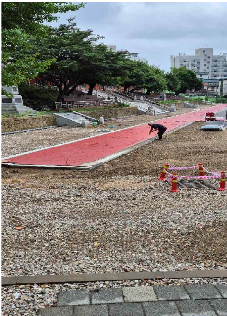
使用高壓水槍清洗排水管後加蓋蓋子防止垃圾流入
